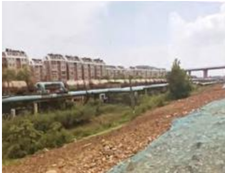
图 1-3 左岸建筑垃圾
