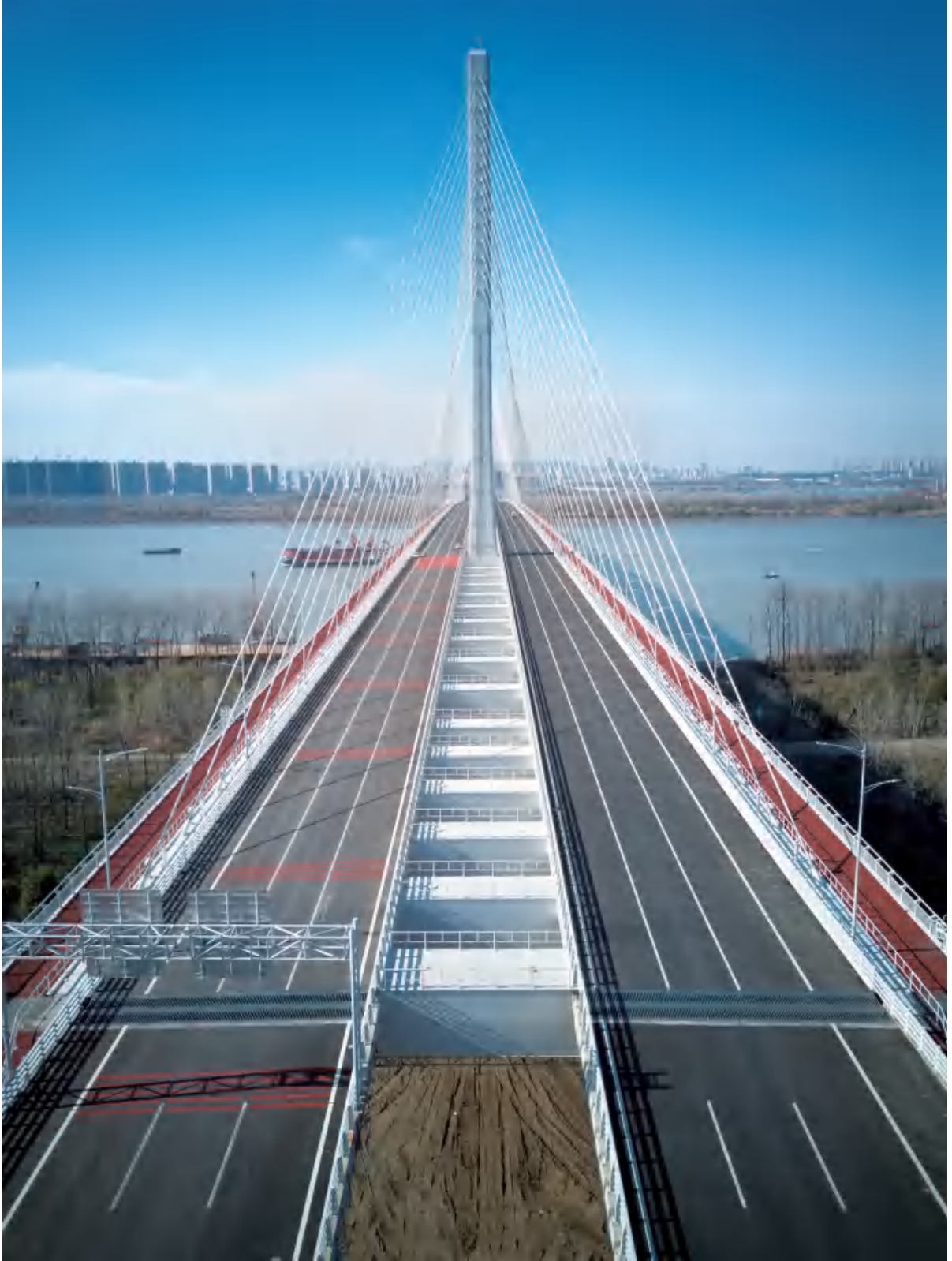
浦仪公路上坝夹江大桥
