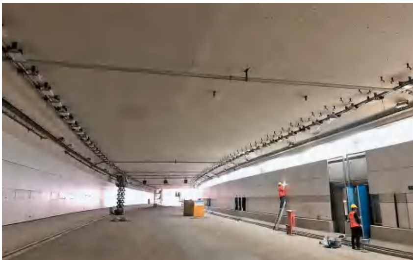
燕子矶过江隧道装饰装修施工现场
