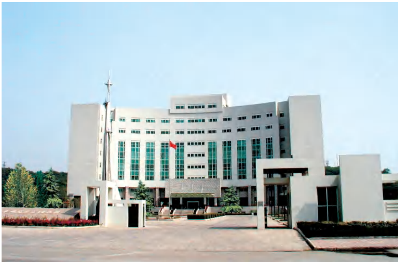
2002年南京经开区管委会大楼
