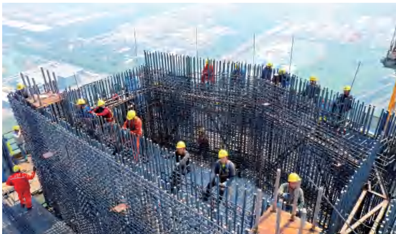
2022年4月20日,建设中的仙新路过江通道
