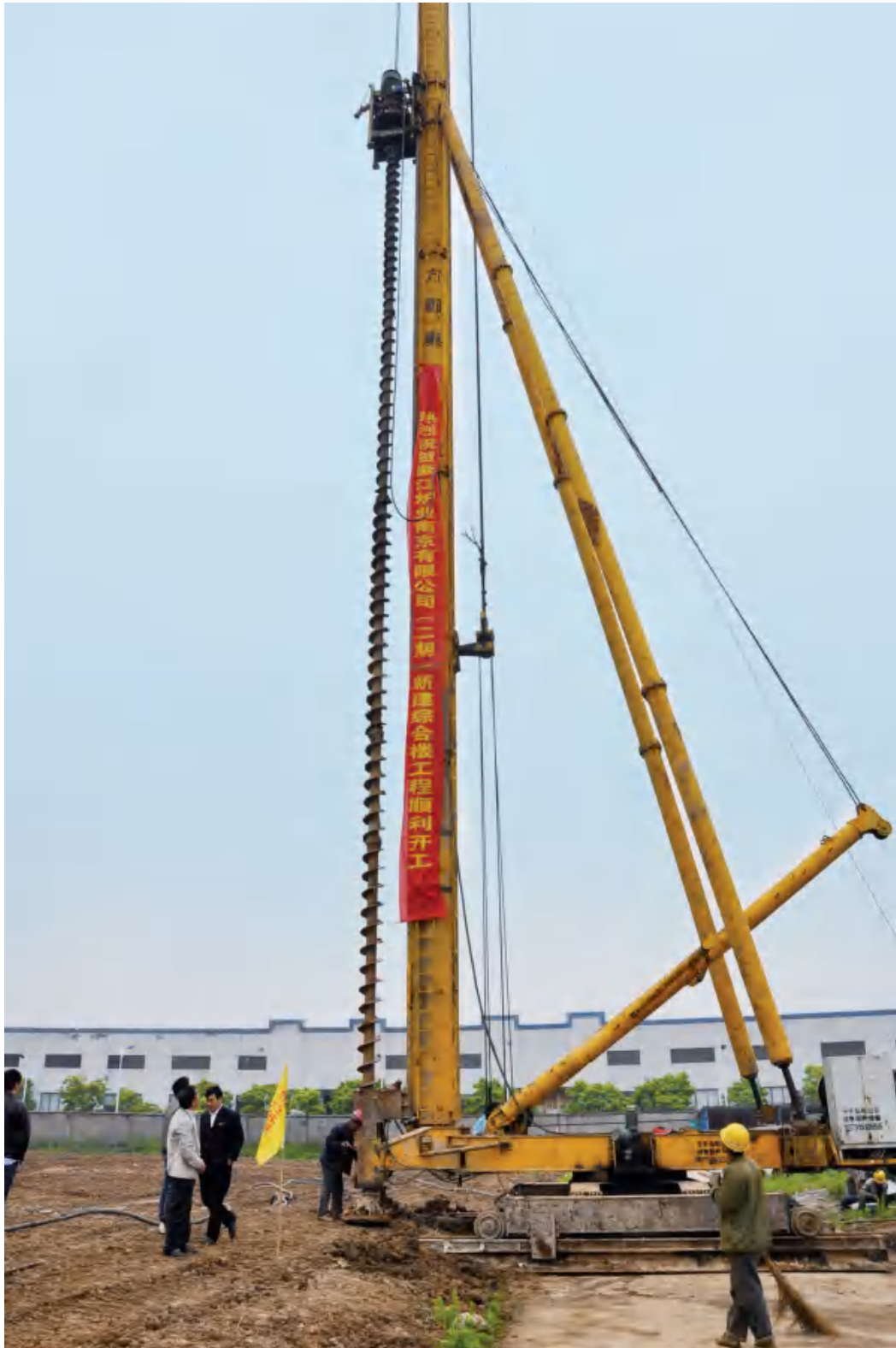
2016年5月18日,紫江炉业第二期新建综合楼工程开工
